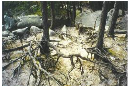
Ces racines nues témoignent de l'ampleur de l'érosion
